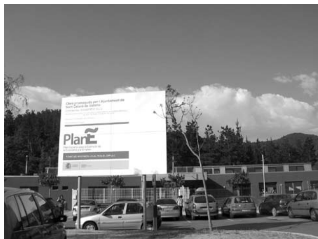
Ampliació espais comuns escola bressol
